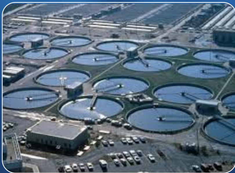
Tratamento de efluentes
